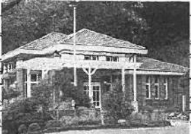
水道山配水事務所 (昭和7年)
