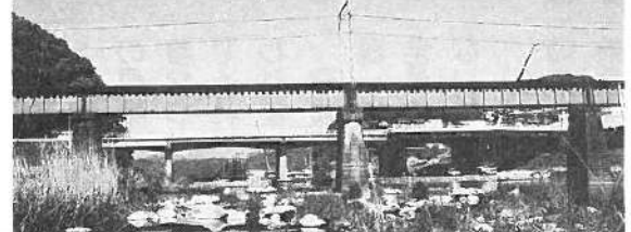
架け替え工事中の赤岩橋 (昭和16年7月架設)
